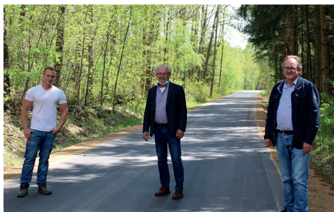
Benedikt Raab (Bauleiter Fa. Georg Huber), Bürgermeister Harald Bemmerl und Michael Throner vom Bauamt der Gemeinde Steinberg am See begutachteten die neue Asphaltdecke kurz nach ihrer Fertigstellung – mit nötigem Corona-Sicherheitsabstand. Foto: Lisa Söllner/VG Wackersdorf-Steinberg am See
