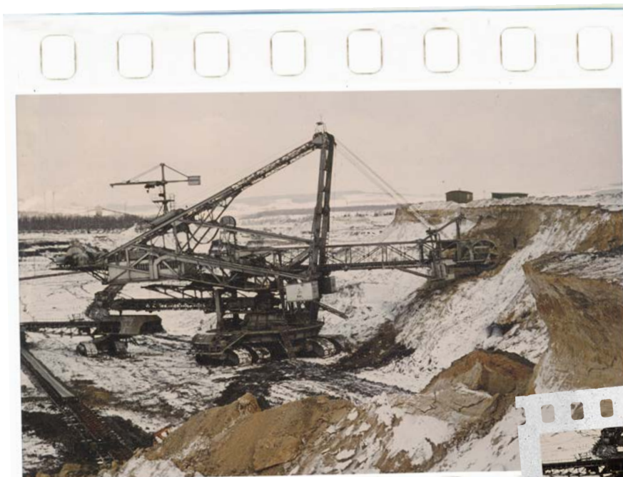
[Bild 3] Mit Einsatz neuer Fördertechnik, dem Schaufelradbagger, entlastete Ernst Meissner die schwer körperlich arbeitenden Bergarbeiter („Hauer“). Außerdem war es jetzt möglich, die Braunkohle auch aus schwer zugänglicheren Erdschichten zu fördern. Foto: private Sammlung Alfred Kerschner
