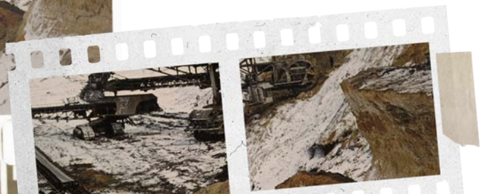
[Bild 3] Mit Einsatz neuer Fördertechnik, dem Schaufelradbagger, entlastete Ernst Meissner die schwer körperlich arbeitenden Bergarbeiter („Hauer“). Außerdem war es jetzt möglich, die Braunkohle auch aus schwer zugänglicheren Erdschichten zu fördern. Foto: private Sammlung Alfred Kerschner
