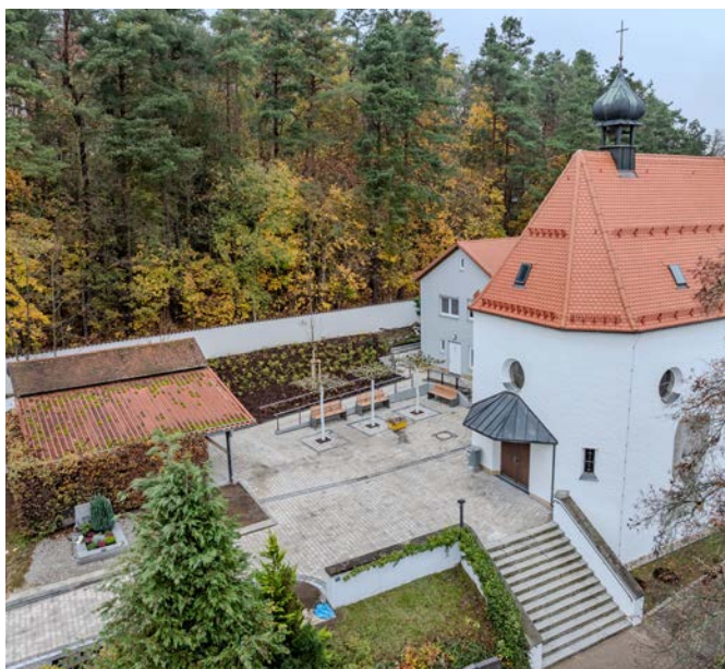
[Bild 1] Die letzten Arbeiten laufen: Noch im Dezember soll der Vorplatz um die Trauerhalle im neuen Glanz erstrahlen. Foto: Mario Bernhardt
