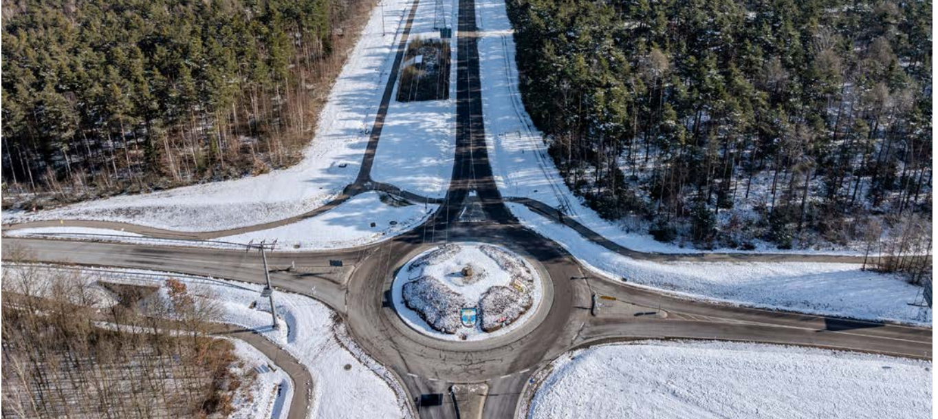
[Bild 1] Im März/April wird die Sanierung der Industriestraße fortgesetzt. Erneuert wird dann der Abschnitt zwischen dem Kreisverkehr an der Kreuzung mit der SAD 9 und dem Kreisverkehr an der Kartbahn. Foto: Mario Bernhardt
