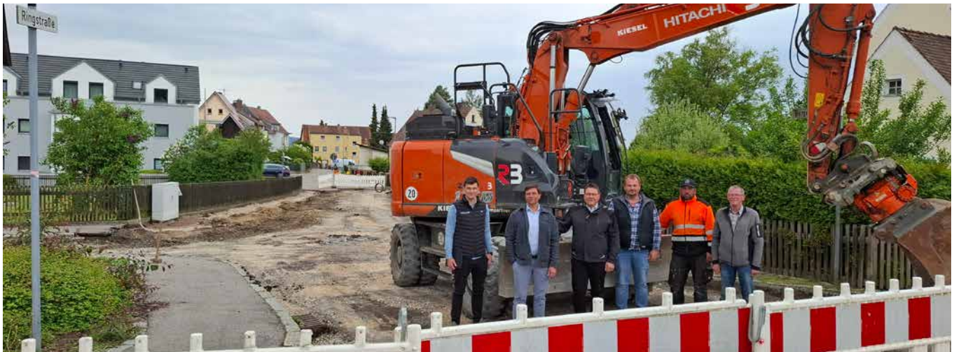
Die Bauarbeiten sind im Einmündungsbereich der Bergstraße gestartet; v. l. Sebastian Riedl vom gleichnamigen Ingenieurbüro, Bauamtsleiter Uwe Knutzen, Bürgermeister Thomas Falter, Bauleiter Tobias Baumann und Polier Daniel Hartl (beide Reger Bau) und Bauhofsleiter Johann Strasser. Foto: Michael Weiß/VG Wackersdorf
